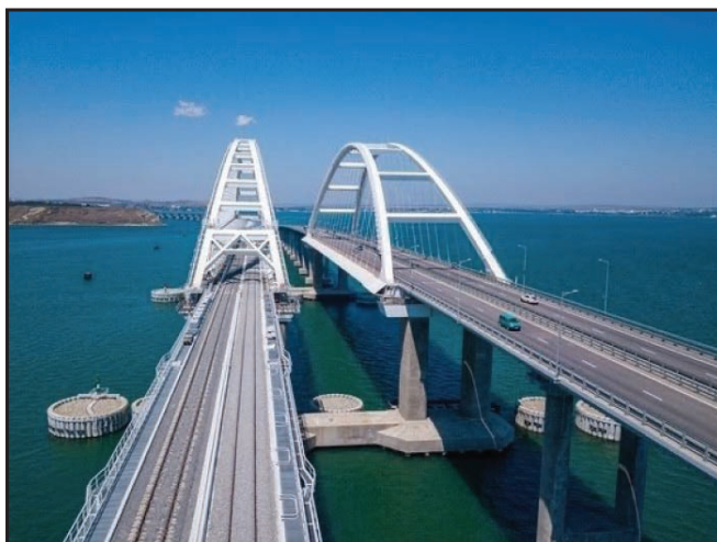
Figura 13 – Ponte da Crimeia
